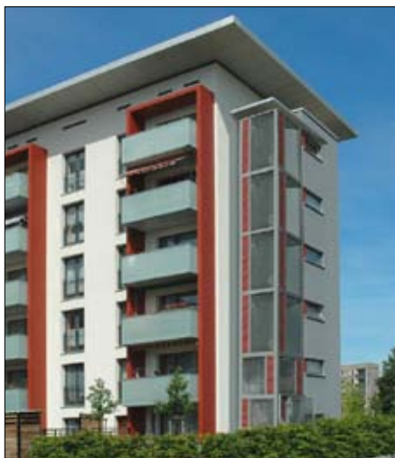
Immeuble tout public équipé d'un VERRALift avec structure autoportante.
