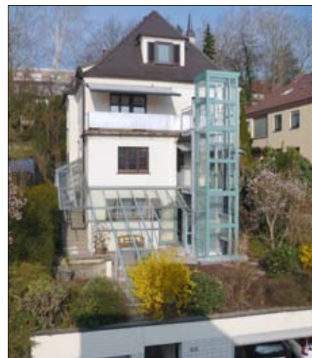
Accessibilité des habitats situés en pente avec un VERRALift.
