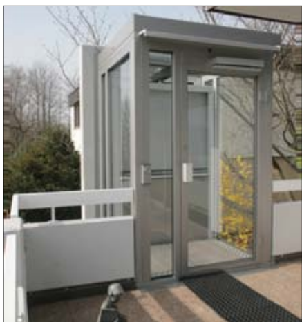
Accès sup. : Des structures modernes avec toit plat et drainage incorporé.
